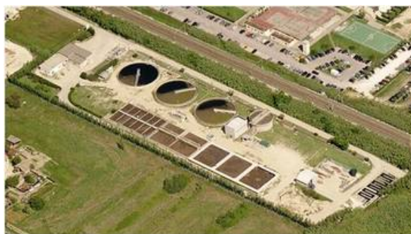
Fig. 4 - Panoramica impianto Ponte Metauro
